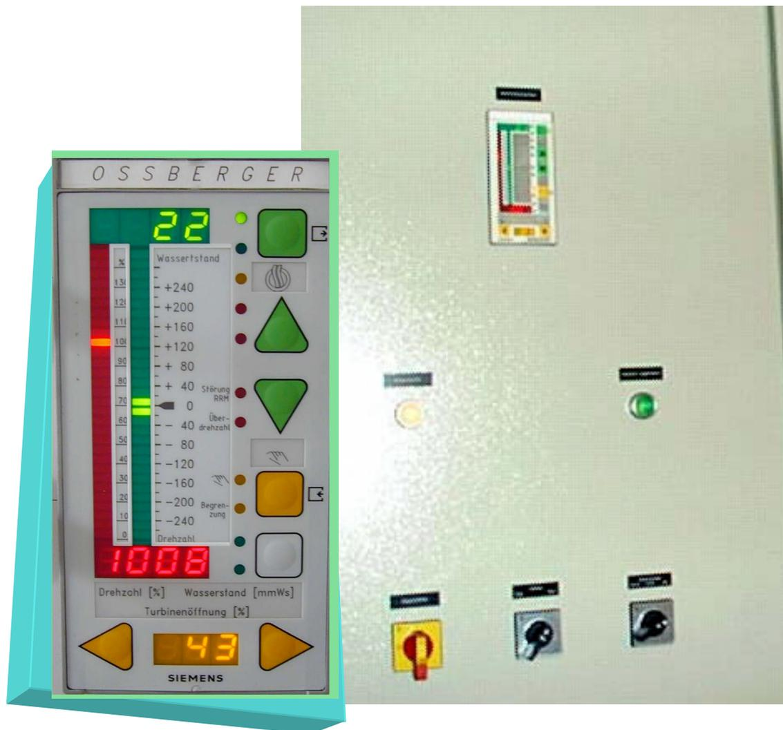
**Schaltschrank**, IP 42, mit Fronteinbaugeräten und bestückter Montageplatte
