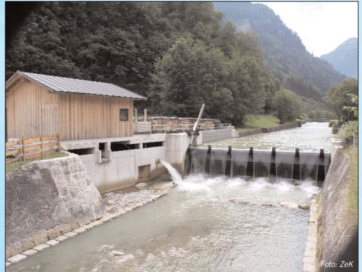
Das KW Hochfilzer nutzt die schwierigen hydrologischen Bedingungen optimal
