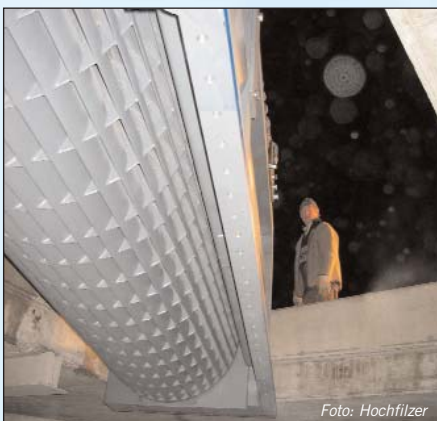
Einbau des Laufrades im Dezember 2003
