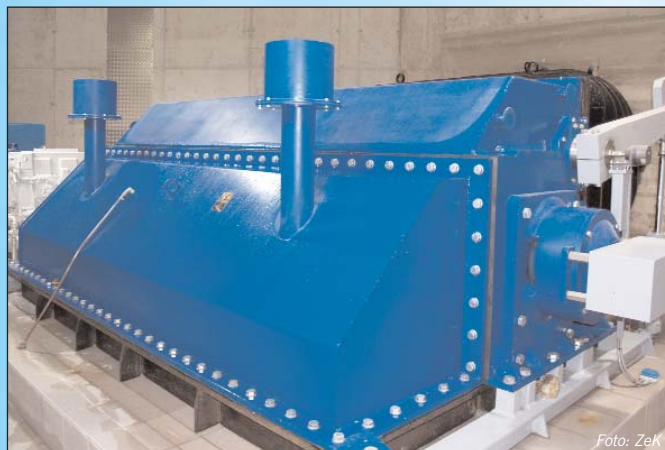
Speziell im Teillastbereich spielt die Ossberger-Turbine ihre Vorzüge aus. Über die Säulen lässt sich das Vakuum im Saugrohr einstellen
