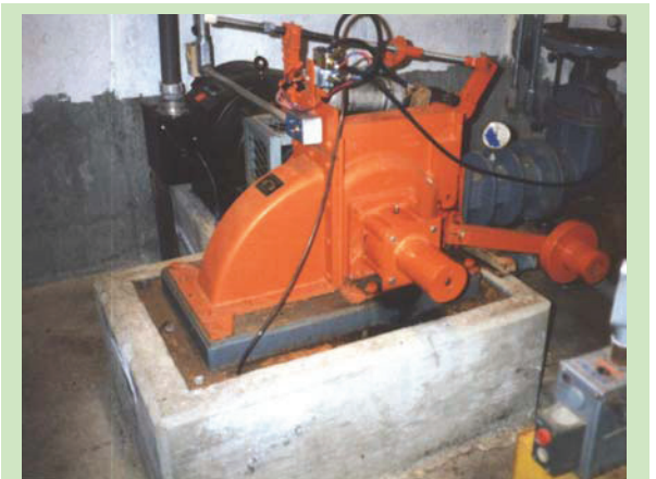
Bild 3: Turbine mit Generator
