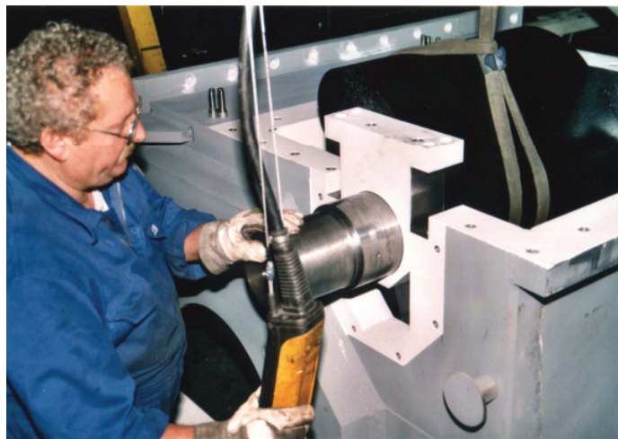
Bild 4: Montage der Leitschaufeln mit Lagereinsatz im Turbinengehäuse
